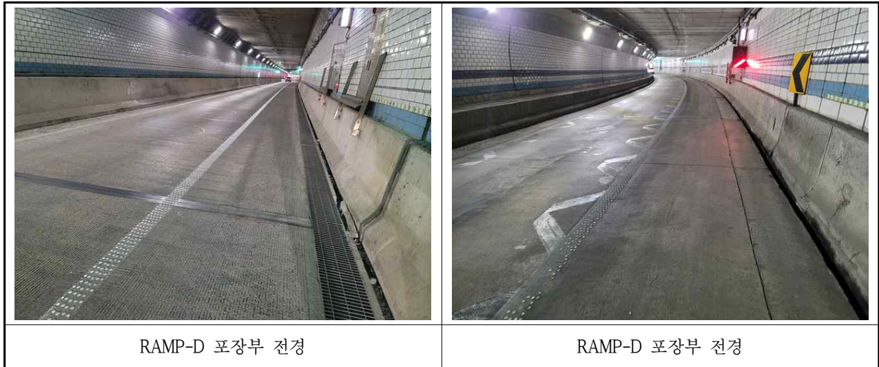
【사진 3.3.29】 포장부 전경
