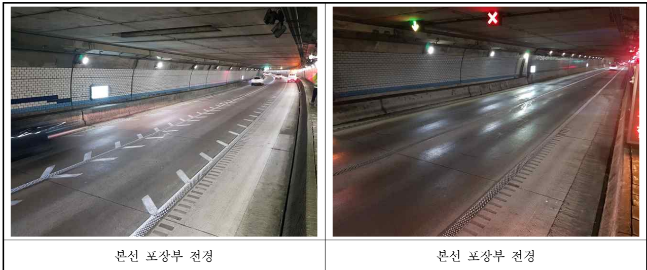
【사진 3.3.11】 포장부 전경
