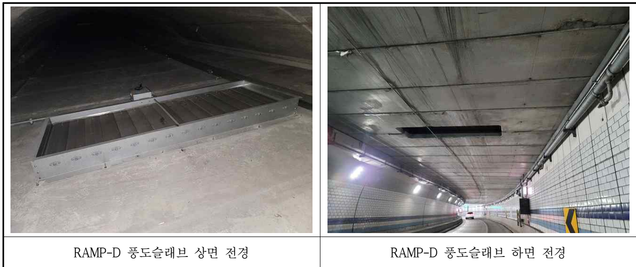
【사진 3.3.27】 NATM구간 풍도슬래브 전경
