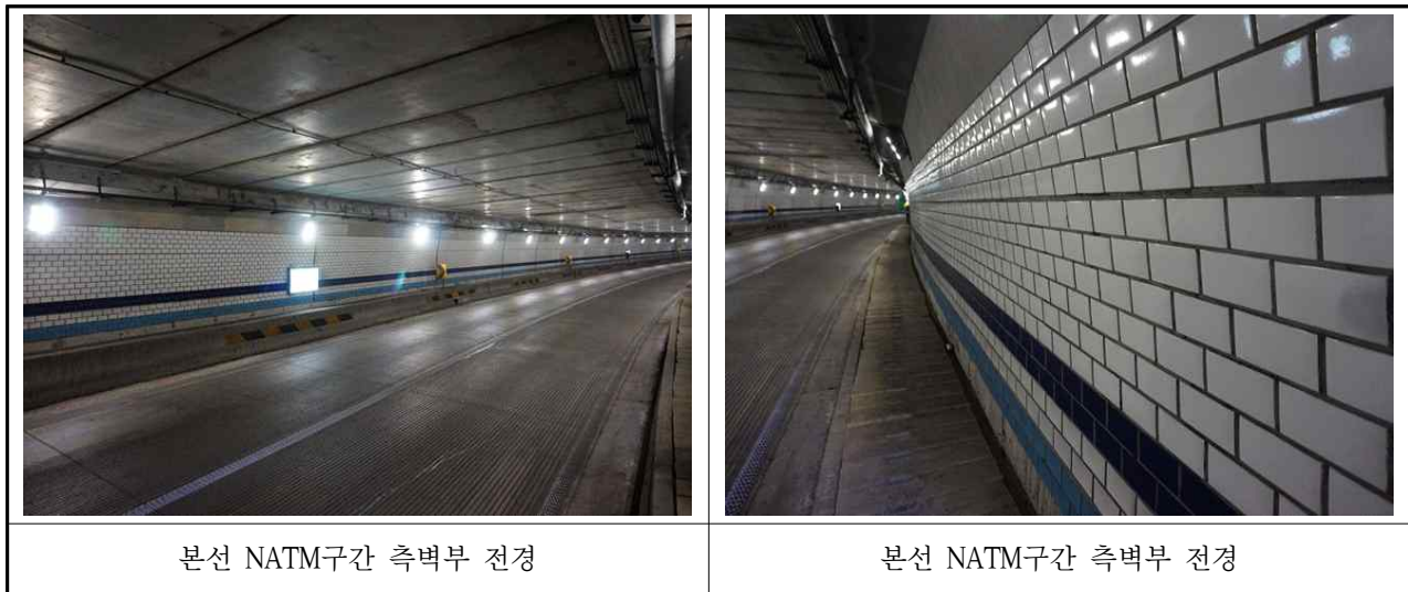
【사진 3.3.7】 NATM구간 측벽부 전경
