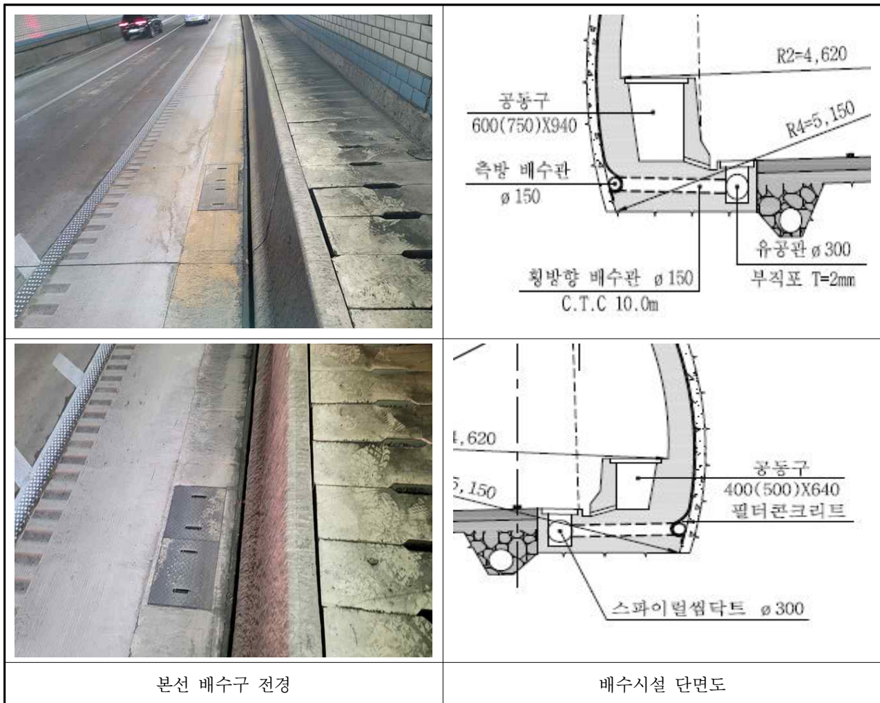
【사진 3.3.15】 배수시설 전경
